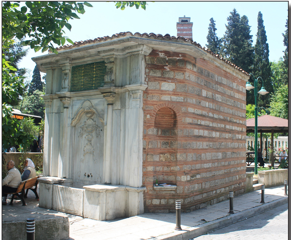
Mihrişah Valde Sultan Çeşmesi.
